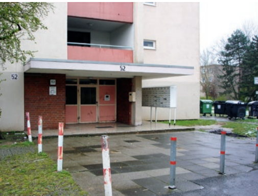
Abb. 5: Unwirtlicher und verwahrloster Eingangsbereich zum Hochhaus Frankfurt Heilmannstraße
